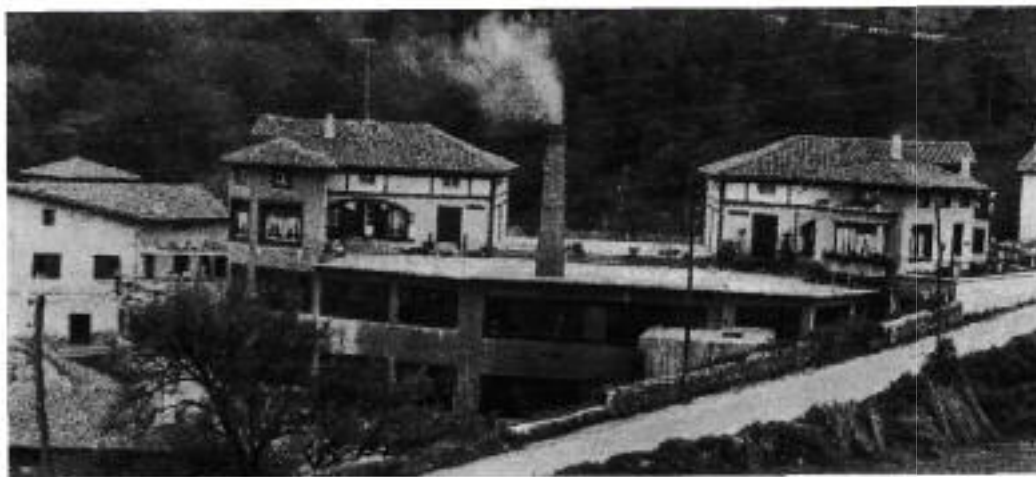
Perratzailianeko fabrikia, 1970 urte aldera
