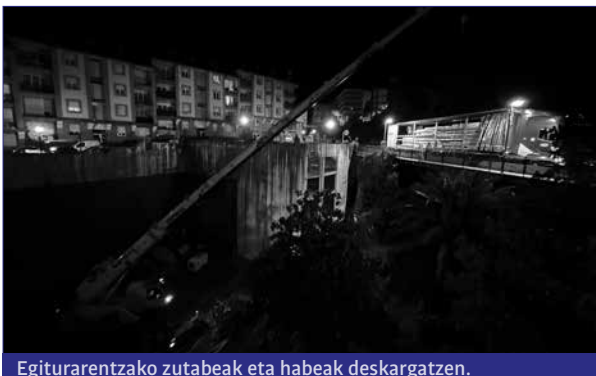
Egiturarentzako zutabeak eta habeak deskargatzen.
