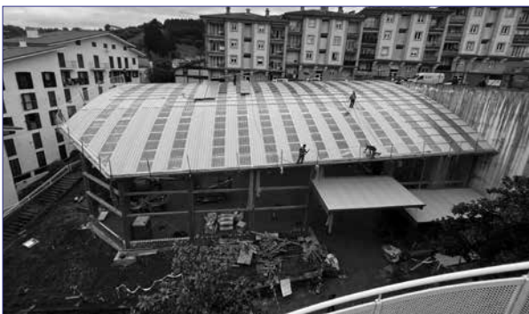
Teilatuaren instalakuntzan erremateak egiten
