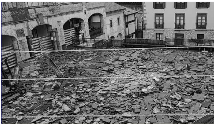
Beheko plazako lurra altxatuta, inpermeabilizazio lanak burutzeko.
